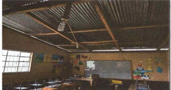
Foto 2: Se observa en el modulo 1 el deterioro de la estructura de soporte de madera en dos aulas
