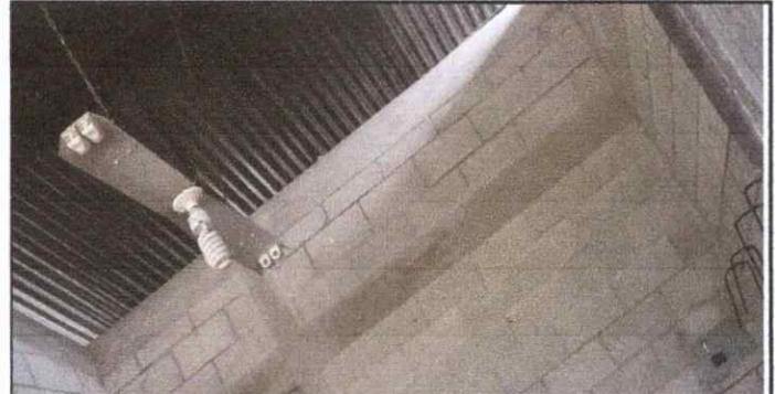
Foto 6: Se observa en mal estado las lamparas y plafoneras.
