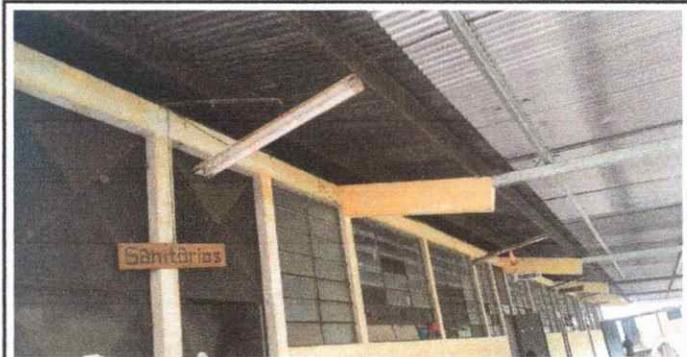
Foto 5: Se observa en el modulo 3, en mal estado el sistema electrico de 7 ambientes.
