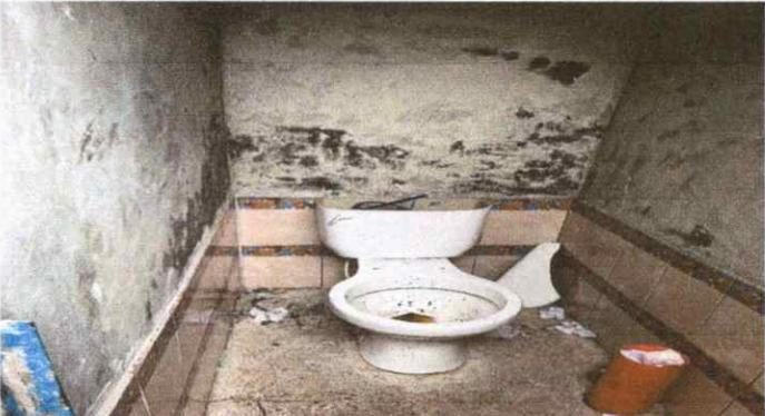
Foto 3: Se observa en mal estado los inodoros en el modulo 2
